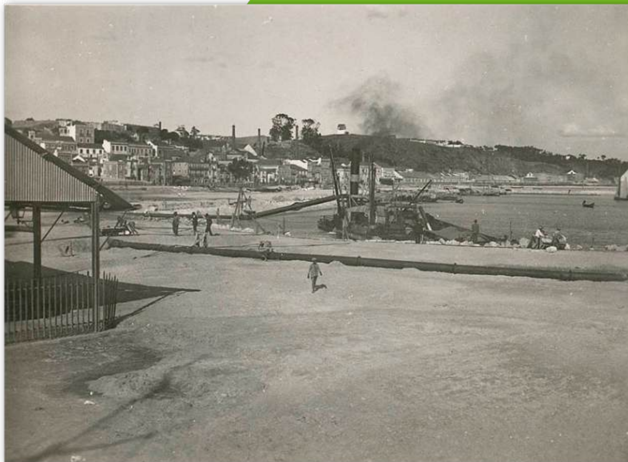
Grandes Obras do Porto de Setúbal de 1930-34 - enchimento com areias • 1933 • Acervo da APSS, SA
