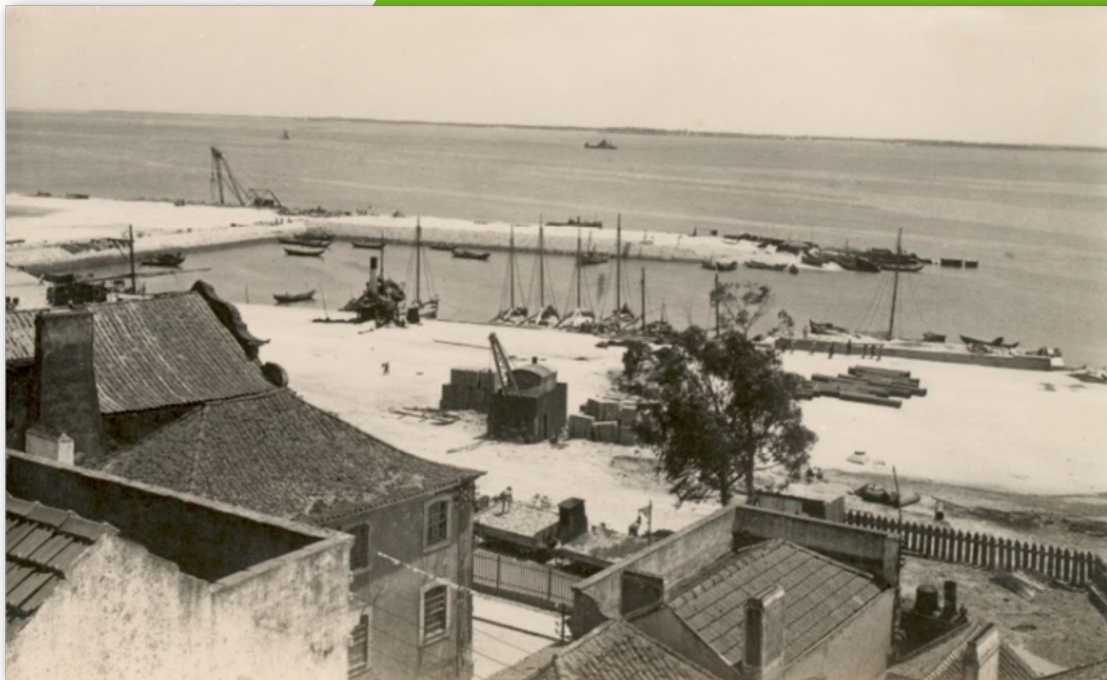
Grandes Obras do Porto de Setúbal de 1930-34 – doca das Fontainhas • 1933 • Acervo da APSS, SA
