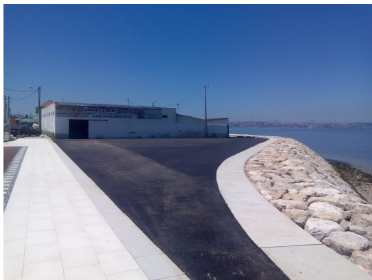
Muralha existente após a conclusão da obra.
