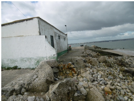
Muralha existente antes da execução da obra.
