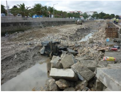
Construção do muro de suporte do avanço
