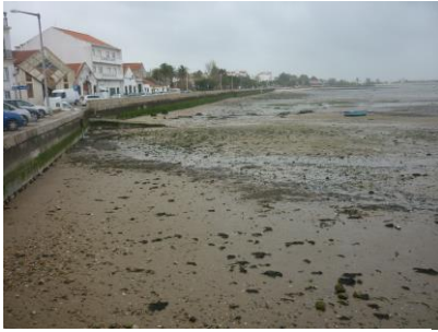
Muralha existente antes da execução das obras
