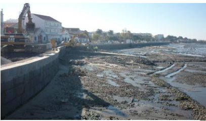
Pavimentação do avanço
